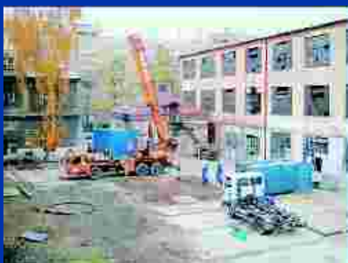
Rekonstrukce Galerie Holešovice
