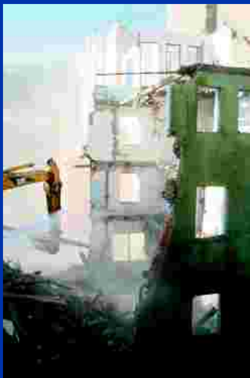
Demolice objektu Dalimilova
