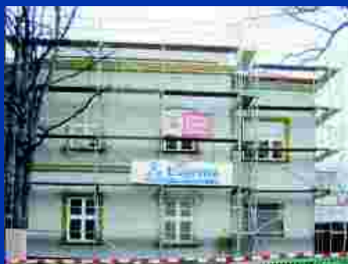
Rekonstrukce objektu Pelléova
